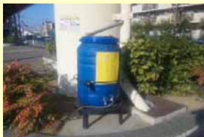
雨水貯留タンク(川西市)
