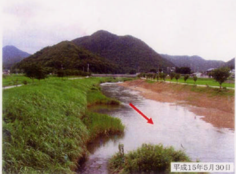
平成14年度施工(左岸)
