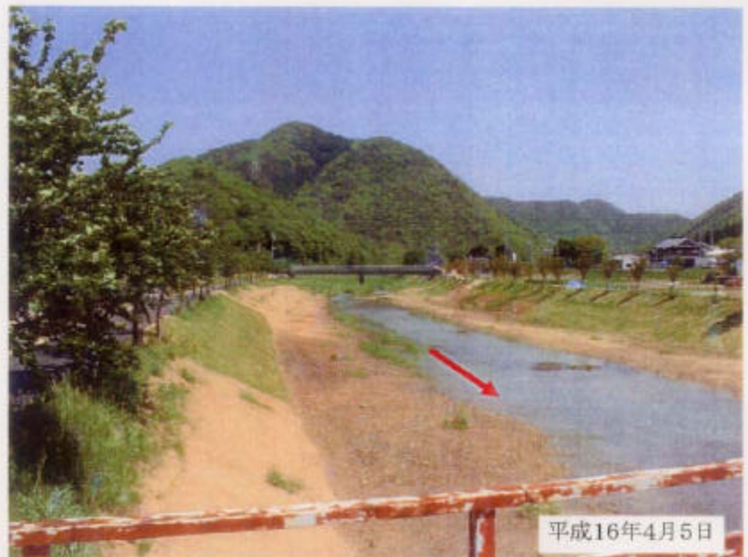
平成15年度施工(右岸)
