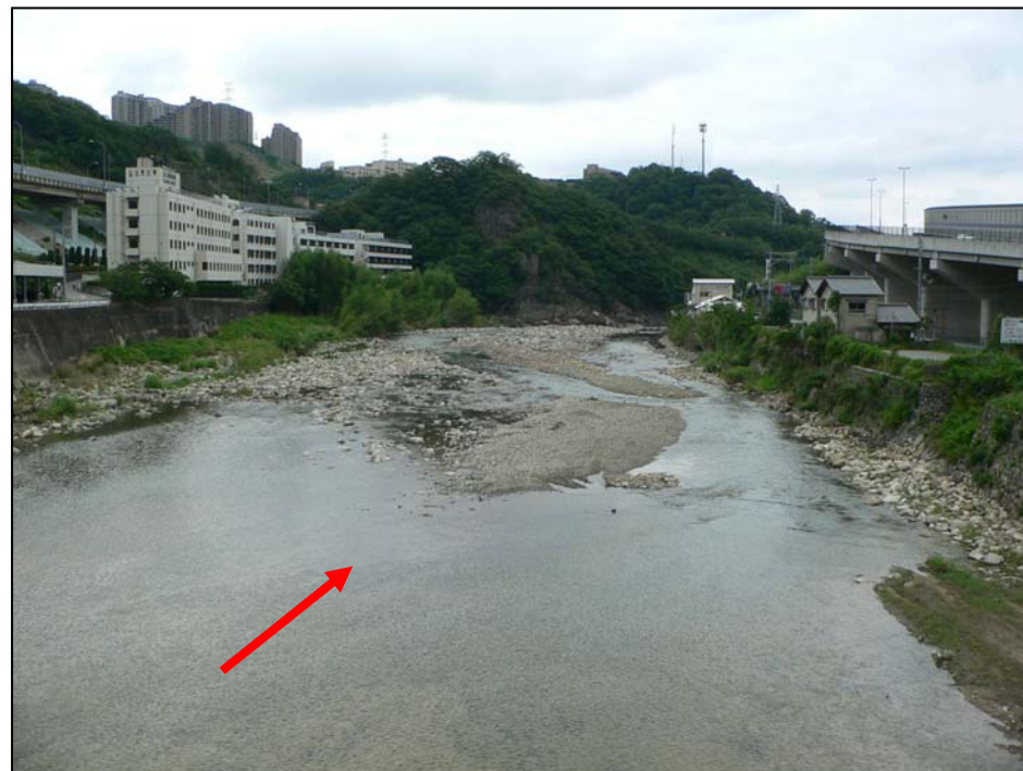
森興橋下流 (16.5k 付近) 現況写真
