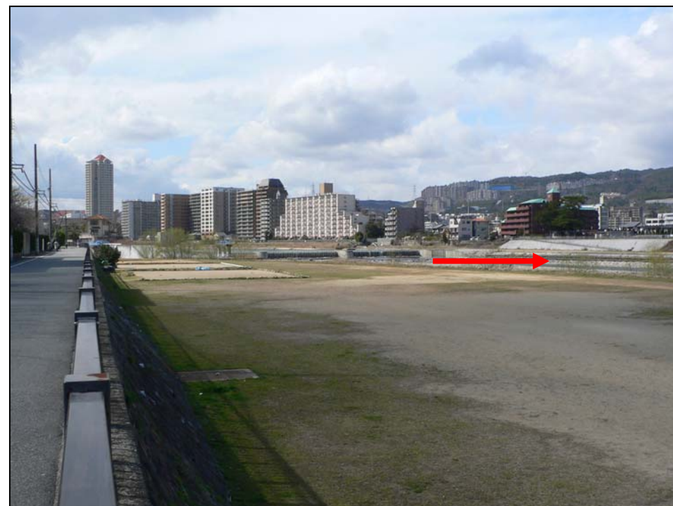
伊子志井堰下流 (13.0k 付近) 現況写真
