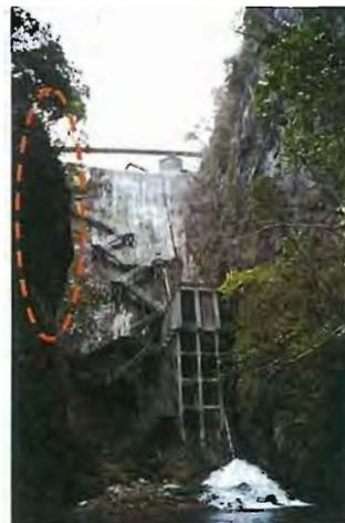
写真-2 改築前の帝釈川ダム（破線内岩塊は破碎・撤去）
