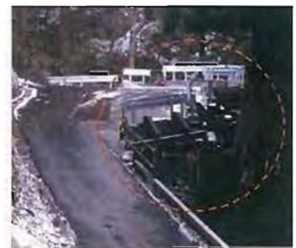
写真-3 カーブ部の谷側に仮設構台を設置
