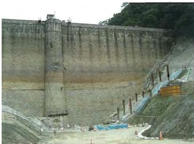
写真-4 堆積土撤出後の堰堤（神戸市水道局）
