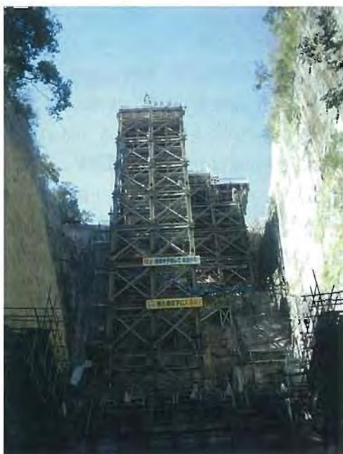
写真-5 ダム下流面を覆う仮設構台
