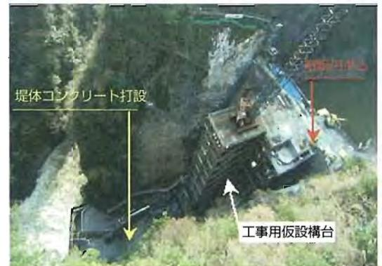
写真-4 ダム堤体下流面に仮設構台を設置
