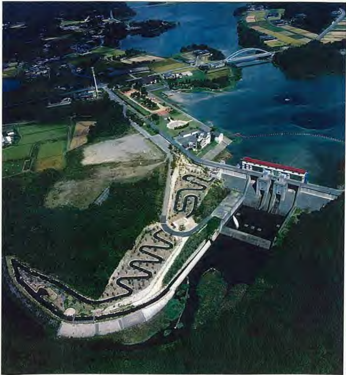
図 2.2.13 青野ダム多自然型魚道
