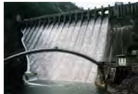
図 2.3.2 千苅ダム堰堤
