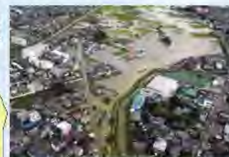
2006年8月29日未明、東京地方は猛烈な集中豪雨に襲われ、東京都府中市では、1時間雨量146.6mmを記録(観測史上1位を更新)。この大雨洪水により、愛知県では、死者6名、2,000世帯以上の床上浸水11,000世帯以上の床下浸水などの被害が発生。(愛知県災害情報センター, 2008)
