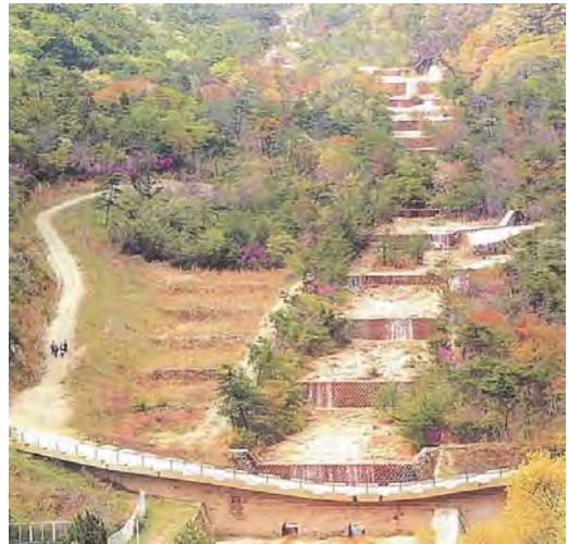
写真 2.1.10 太多田川砂防えん堤群
