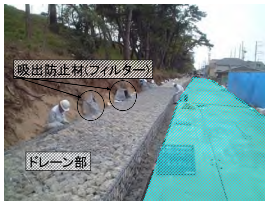
写真 2.2.4 堤防強化工事の例(ドレーン工)
