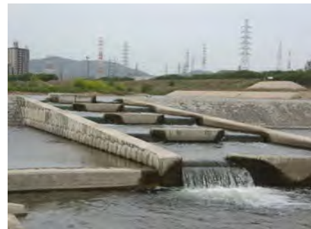
写真 2. 2. 24 床止めに設置された魚道
