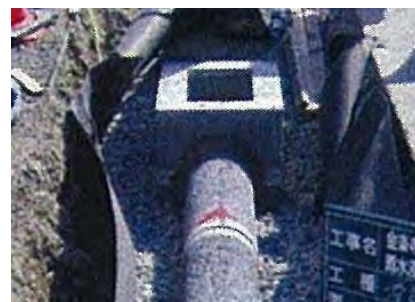
写真 2.2.11 浸透側溝
