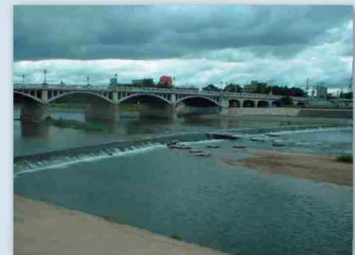
武庫大橋下流の堰
