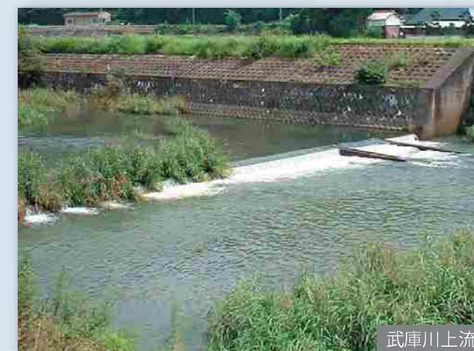
移動の連続性を分断する横断工作物の例
