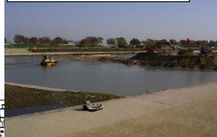
H20河床掘削工事 状況写真
