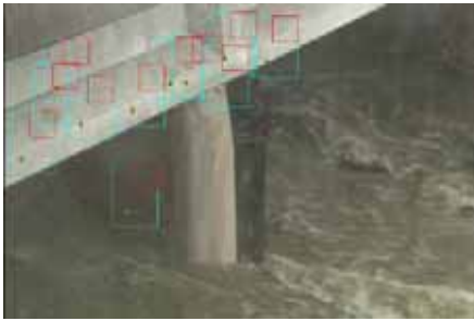
図-9 新都賀川橋橋脚周辺の流況（四角の部分ブレ補正用の目印）
