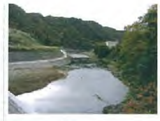
⑪大岩橋から右岸武庫川上流浄化センター増設用地をみる
