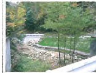
②川下川ダム下流(H16年23号台風の災害復旧箇所)
