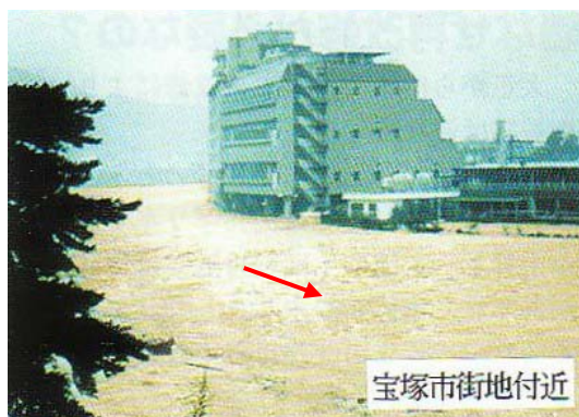
写真 2.1.6 昭和58年台風10号による浸水の状況（宝塚市街地付近）
