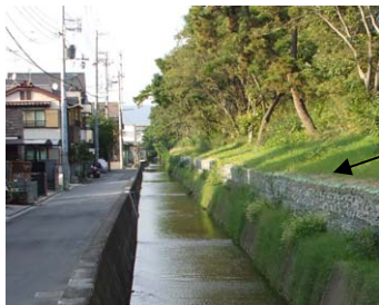
写真 4.1.1 ドレーン工法※の施工例
