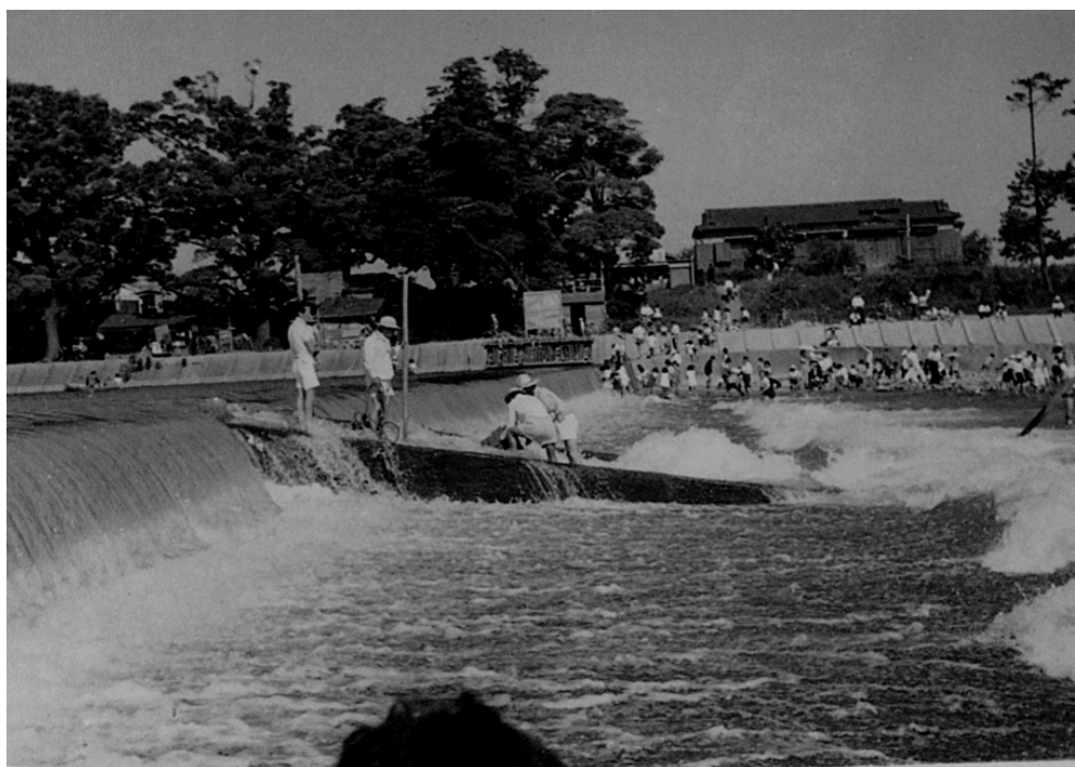
図 7.3.2 武庫川河口堰（現在の潮止堰）の様子（昭和31年7月12日撮影）
