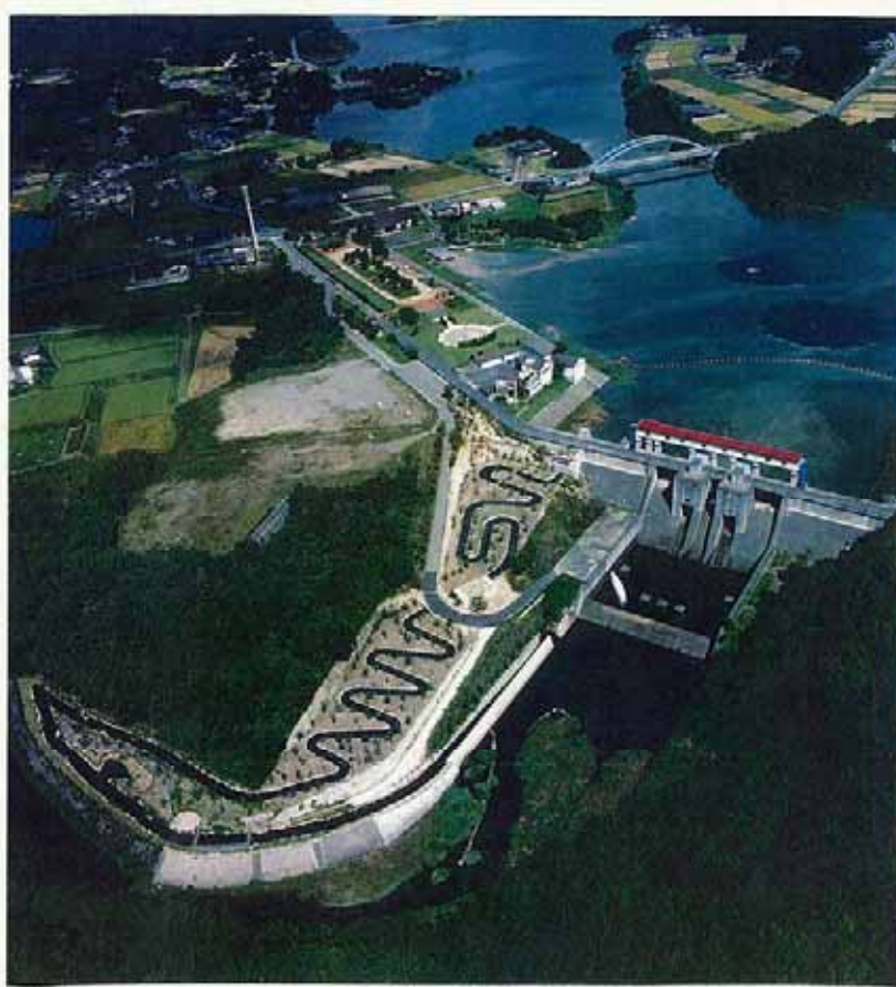
図 2.2.12 青野ダム多自然型魚道
