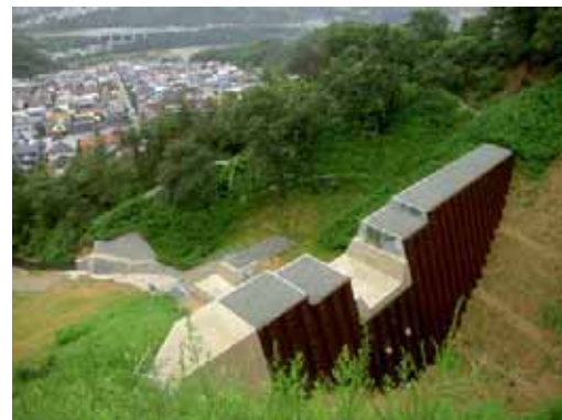
図 4.3.6 人家を守る土石流対策えん堤 高雄谷川（西宮市塩瀬町生瀬）
