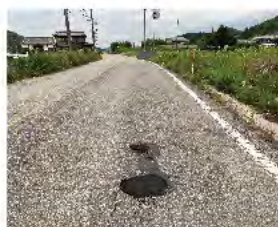
穴ばこの補修作業
