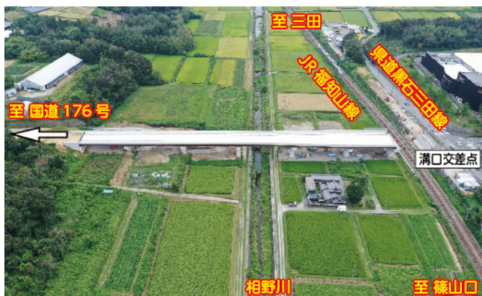
（主）三田西インター線（三田市）
