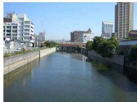
写真) 下流域(庄下川)の様子 (尼崎市)
