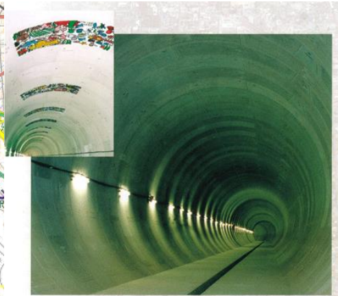
施設（貯留管）の内部
