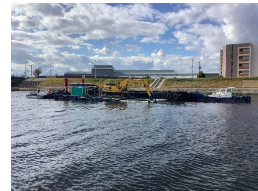
河道掘削（浚渫）工事写真
