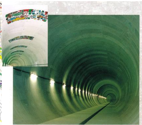
施設（貯留管）の内部
