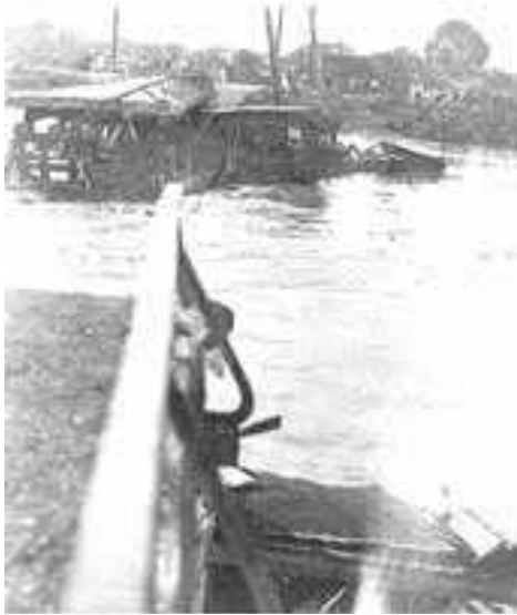
写真) 真っ二つに折れた神崎橋 (昭和13年7月)
