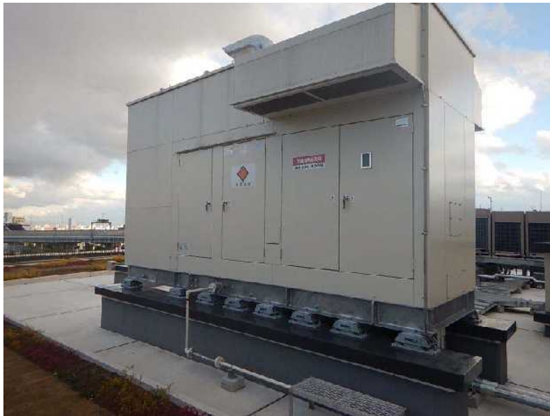
自家発電装置を庁舎屋上に設置
