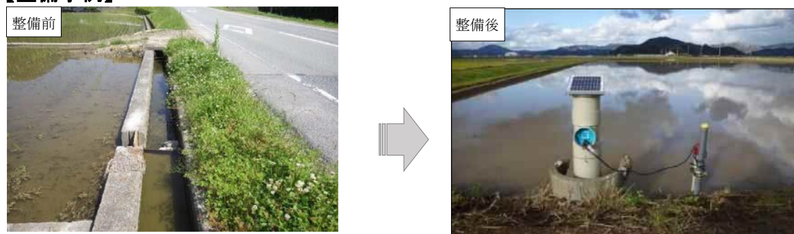
管路化（パイプライン化）
