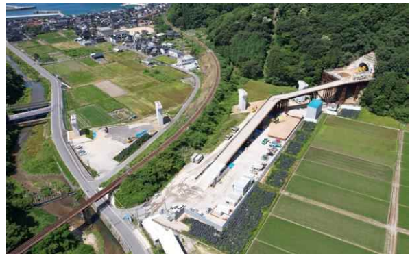
浜坂道路Ⅱ期 浜坂第2トンネル～ 諸寄高架橋（新温泉町）
