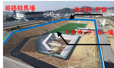
●船場川洪水調節施設
