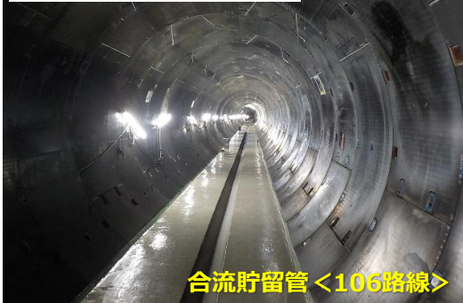
<合流貯留管完成写真>
