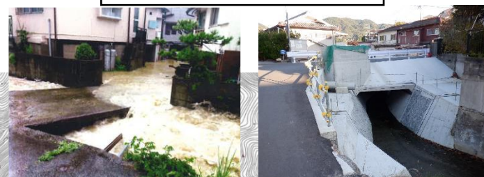
ネック部改修(R3完成)
