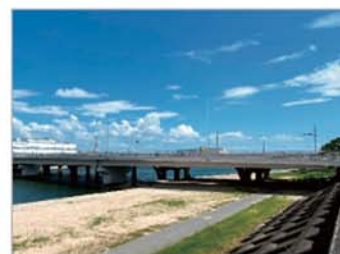
【南武橋架替工事】
