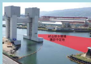
⑨ 新川水門、新川・東川統合排水機場(西宮市)
