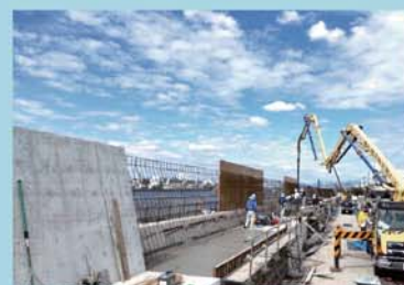
⑤ 丸島西護岸(尼崎市)
