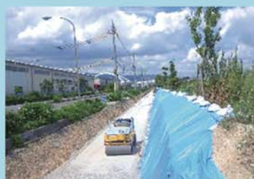
⑦ 甲子園浜西防潮堤(西宮市)
