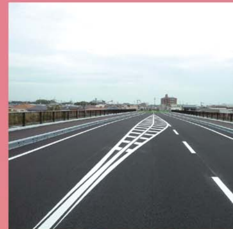
園田西武庫線(藻川工区)新藻川橋
