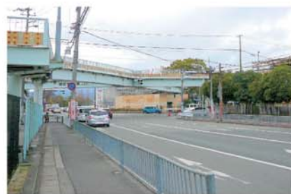
【県道米谷昆陽尼崎線 芦原歩道橋(尼崎市)】
