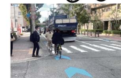
【車道混合(矢羽根型路面表示) (西宮市道市役所前線)】
