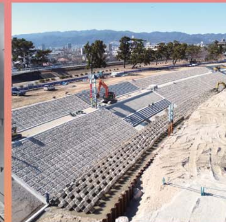
武庫川護岸整備
