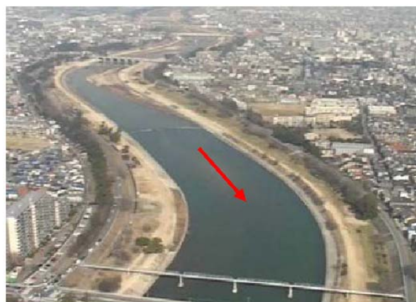
図 2-3 下流部築堤区間
