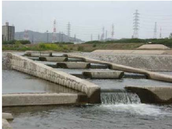
図 2-6 床止めに設置された魚道
