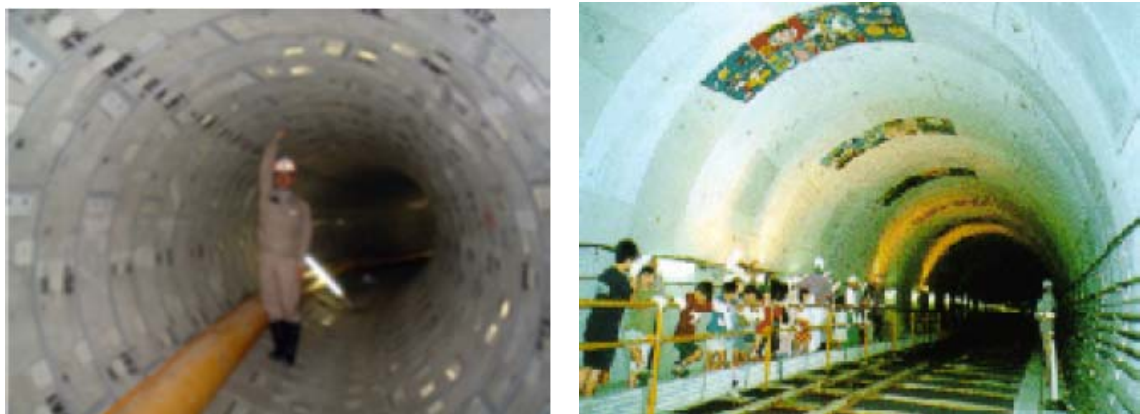
図 5-10 雨水貯留管 (左：西宮市、右：伊丹市)
