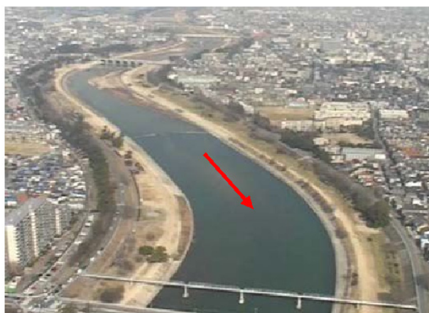
図 2-3 下流部築堤区間
