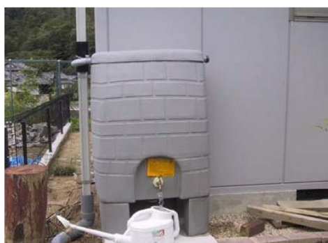
図 6-9 その他の雨水貯留・浸透の取り組み（左：雨水貯留タンク、右：浸透管・浸透柵）
