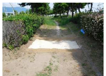
完成（施工直後）
