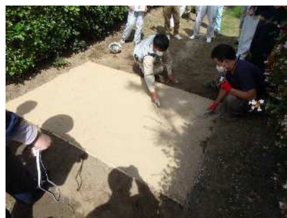
施工状況（コテ仕上げ）
