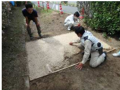
施工状況（敷き均し）
