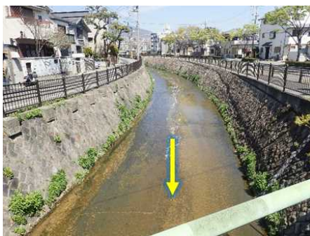
河川の状況（中流部）
