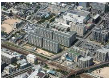
写真③ 発進立坑周辺
