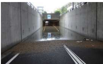
写真② [平成25年] 市道(北口線アンダーパス)
