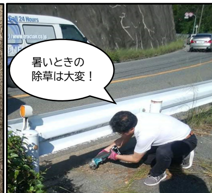
作業中の様子
