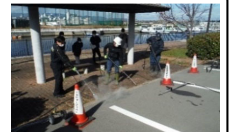
アイデアコンテスト提案技術の試験施工
