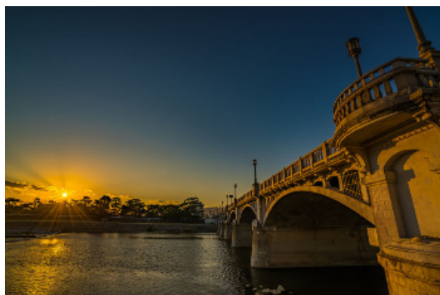
国道2号上にある武庫川に架かる武庫大橋(西宮市)
