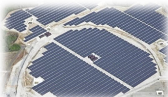
播磨科学公園都市第1発電所
