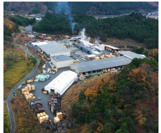
協同組合 兵庫木材センターの全景
