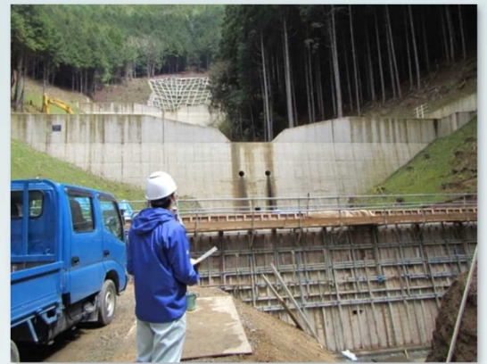
施工中の治山ダムの現場を確認
