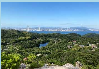
淡路島公園からの明石海峡大橋
