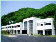
センター研究棟
