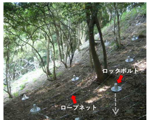
R・R併用工法を施工した山腹斜面
