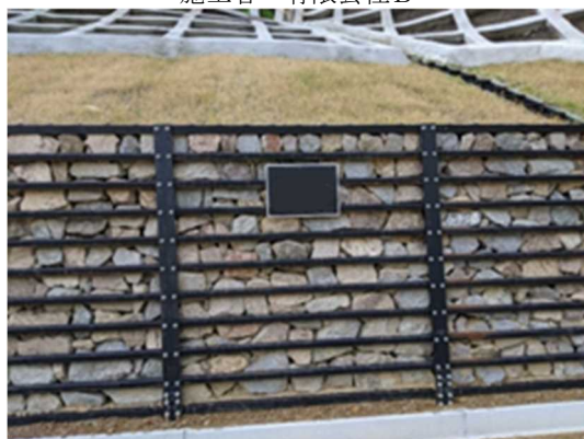
<令和元年度（30災第1号）治山事業> 施工者 有限会社B
