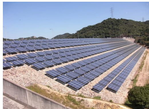
【権現ダム堤体法面】
