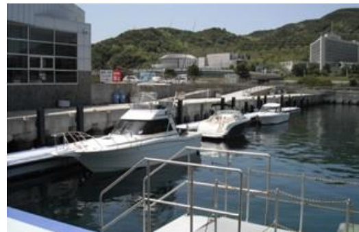
プレジャーボート係留施設
