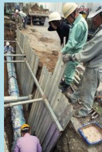
阪神淡路大震災発生後の水道復旧工事
