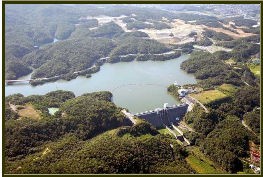
呑吐ダム (神出浄水場水源)
