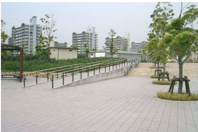
スロープを伴った階段の整備(親水中央公園)
