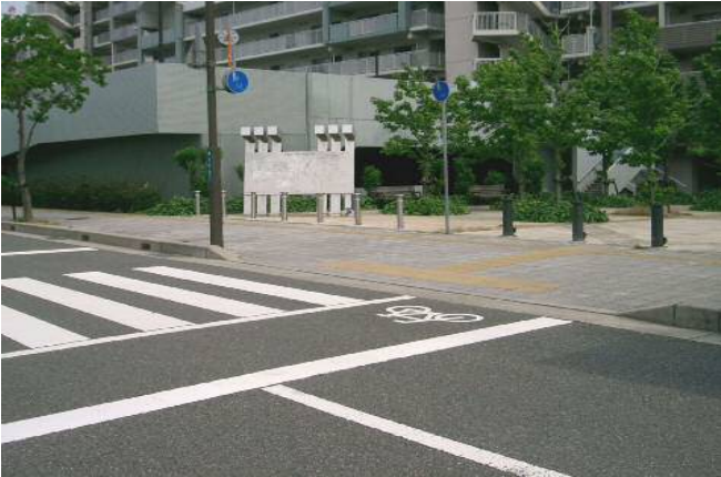
歩道の段差解消
