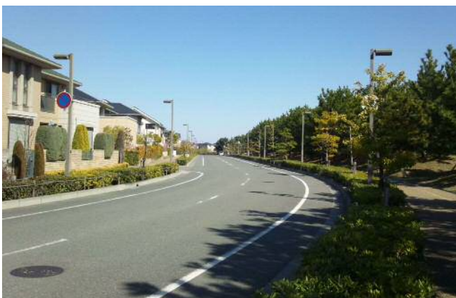
電線類地中化の整備
