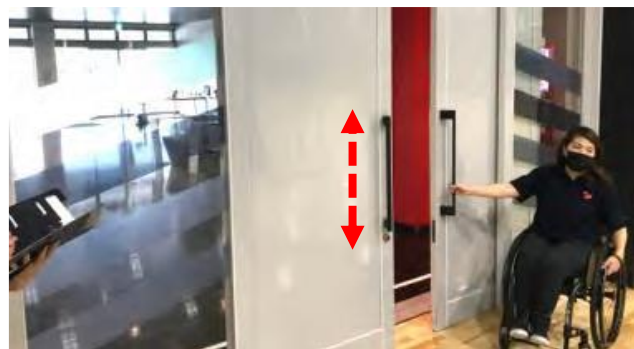
・棒状の取っ手を採用し、取っ手の長さを長めに設計 (日本財団パラアリーナ)
