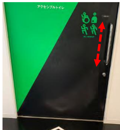
・棒状の取っ手を採用し、取っ手の長さを長めに設計 (日本財団パラアリーナ)
