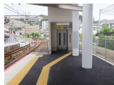
鉄道駅におけるエレベーター設置
