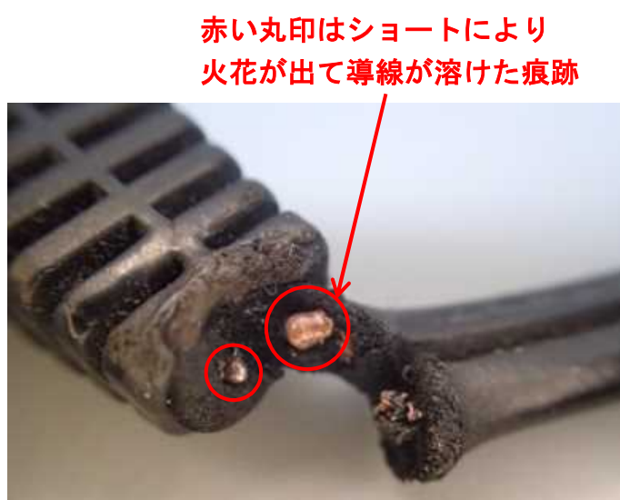
断線箇所の拡大写真
