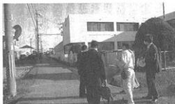
基幹管路の更新現場を見学(右の建物は播磨町第3浄水場)
