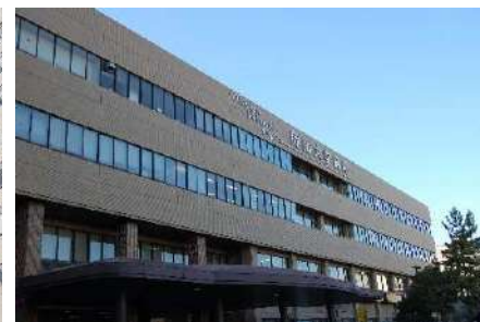
岡山大学病院外来棟
