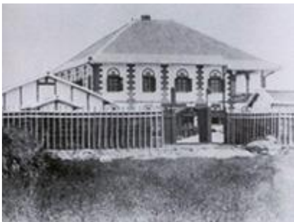
明治2年 神戸病院の洋風建築
