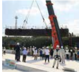
きょうりょうかせつ 橋梁架設を親子で見学
