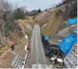
県道神戸加東線 桃坂バイパス
