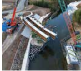
県道小野藍本線 松沢バイパス
