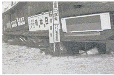
中央区加納町付近の浸水状況(提供: 神戸市)。
